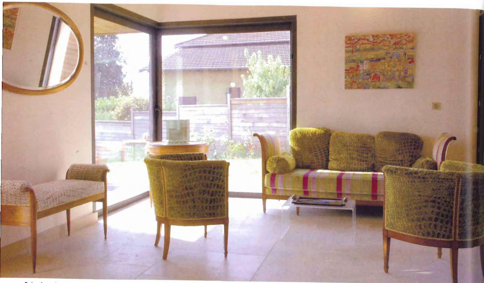
Galandage. Les deux panneaux de la grande baie vitrée coulissent à l'intérieur des murs, derrière le parement intérieur, livrant un généreux passage entre le salon et la terrasse extérieure.
