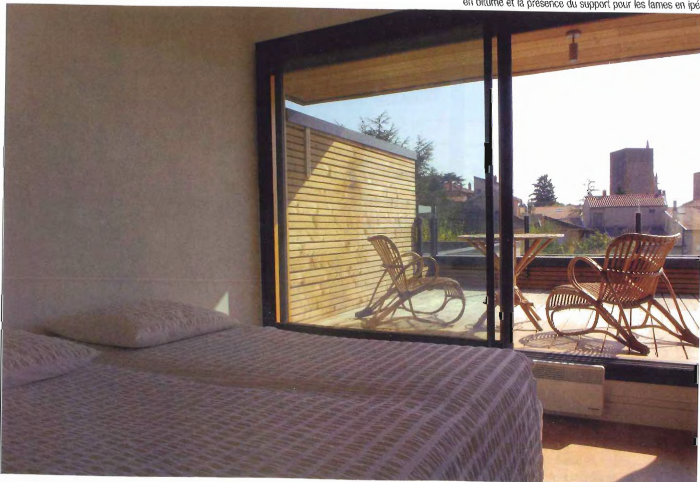
Chambre. Cette chambre s'ouvre sur une vaste terrasse aménagée au-dessus de la cuisine du rez-de-chaussée. La différence de niveau, qui a permis de loger le convecteur radiant sous la baie coulissante, se justifie par l'étanchéité en bitume et la présence du support pour les lames en ipé.
