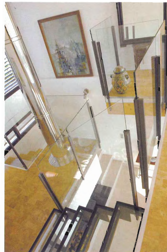
L'escalier à l'arrière de la maison s'enroule autour de la cheminée. Ses marches et son garde-corps marient l'aluminium et le verre pour laisser passer la lumière et ne pas briser l'espace. Le sol est en panneaux de liège passés à l'huile dure.
